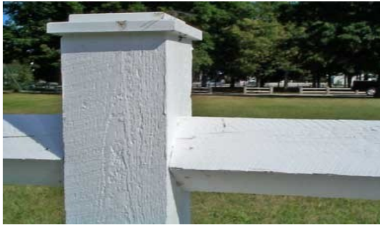
Butt-joint (acceptable)
